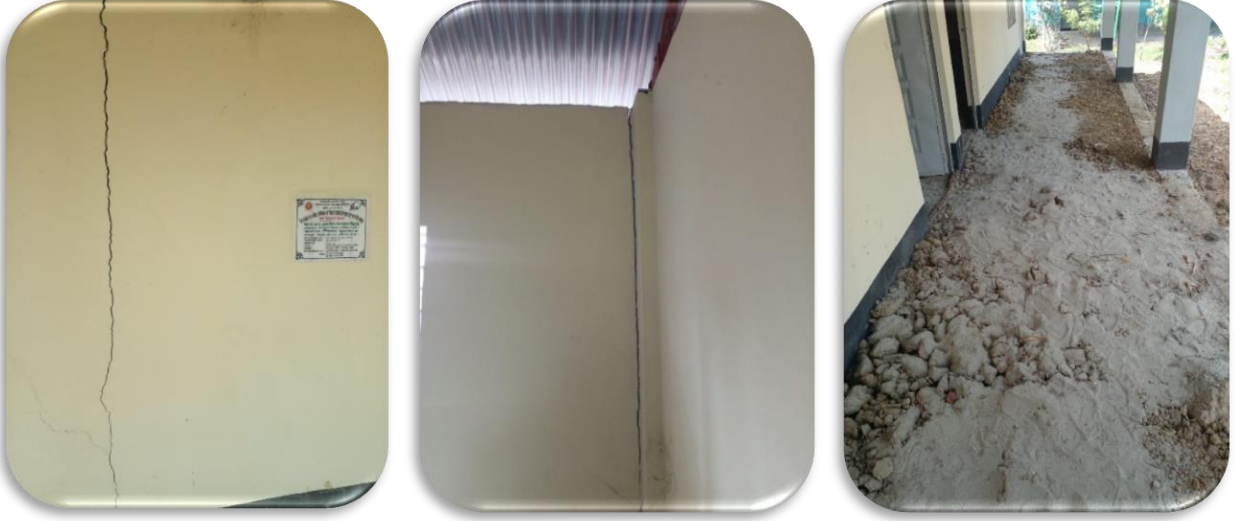
চিত্র ৩.৬: নন্দীগ্রাম টেকনিক্যাল এন্ড বিজনেস ম্যানেজমেন্ট কলেজ, নতুন ভবন নির্মাণ প্রকল্প, নন্দীগ্রাম উপজেলা, বগুড়া
